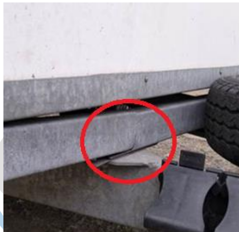
Foto 2. Gebrochener Balken, der durch Überlastung beschädigt wurde - Mängel können nicht reklamiert werden
