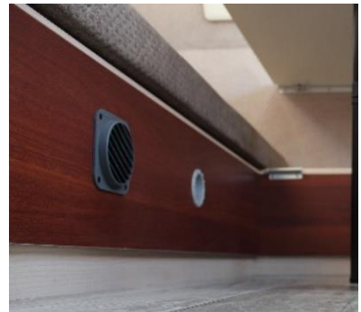
Photo 8. Ventilation dans les caisses du coin à dormir
